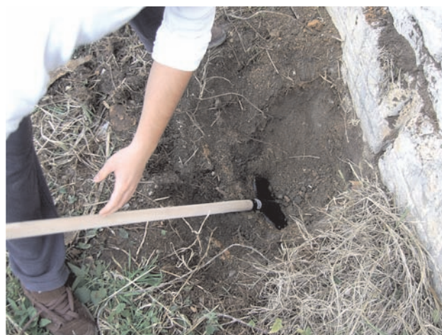
Figure 5 Digging the ground Slika 5 Otkopavanje temelja
