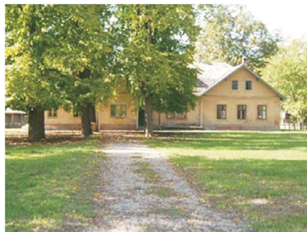
Figure 4 Administration Building in Zlatna Greda Slika 4. Upravna zgrada u Zlatnoj Gredi
