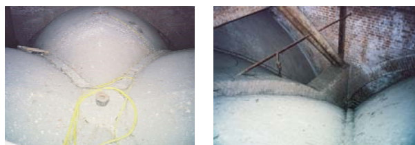
Slika 7. Ekstrados i oslonac svođene konstrukcije
