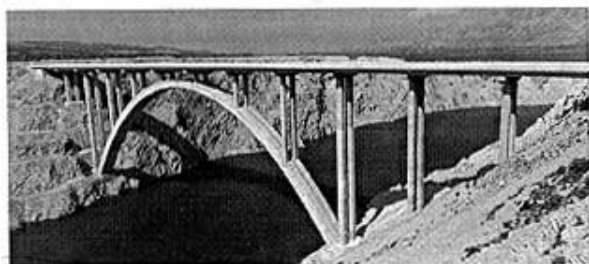
Slika 10. Izgled dovršenoga Masleničkog mosta
