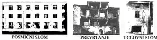
Slika 1. Karakteristična oštećenja kamenom zidanim zgradama u potresu
