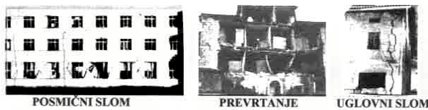
Slika 1. Karakteristična oštećenja kamenom zidanim zgradama u potresu
