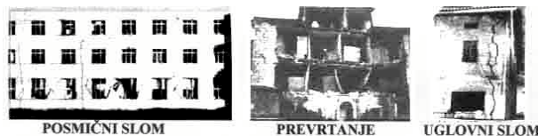
Slika 1. Karakteristična oštećenja kamenom zidanim zgradama u potresu
